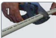
Cortar en ángulo recto la sección de tubo. En caso de usar tubería multicapa es obligatorio calibrar y biselar.
