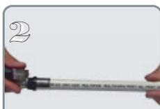
Introducir el extremo del tubo en el accesorio hasta hacer tope, visualizar su correcta colocación.
